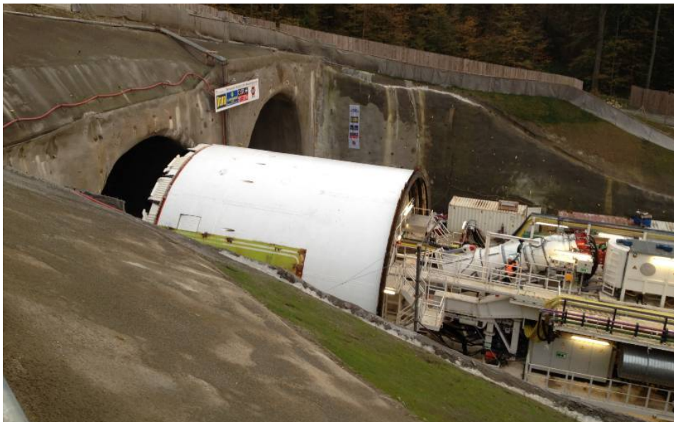
Tunnelbohrmaschine Eingang Boßler-Tunnel am Aichelberg
